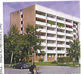
Das Margarete-von-Siemens-Haus aus den 70er-Jahren bietet Senioren Privatsphäre in der eigenen Wohnung und mit umfangreichen Serviceangeboten Sicherheit im Notfall.
